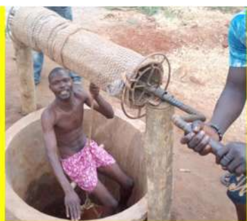
Forage du puits
